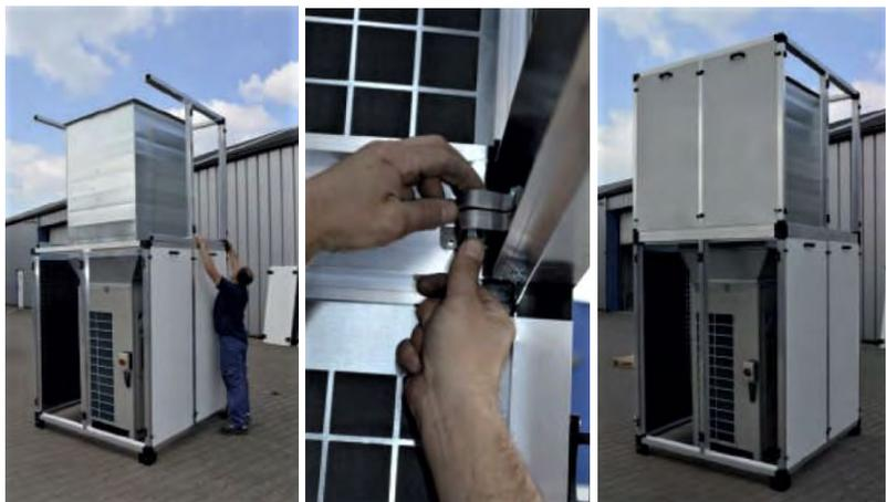
Falls eine Türe bestellt würde wird die ähnlich eingesetzt wie die Schalldämmpaneele auf ein vordefinierte Platz in der Aluminiumrahmenkonstruktion mittels Doppelscharniere zum einfachen öffnen mittels Doppelbartschlüssel (sowohl nach links oder nach rechts) oder ist vollständig entnehmbar.
