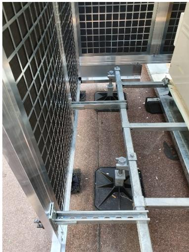
Beispielbild Montage mit Klemmverbindung zur Stahlrahmen:
