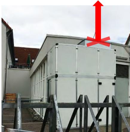
Somit wird die Oberkante Kulissenschalldämpfer auf dem gleichen Niveau sein wie die Oberkante Schalldämmwand, und ist die Verbindung zwischen Außengerät und Kulissenschalldämpfer und dadurch bei extremer Windlast weniger belastet.
