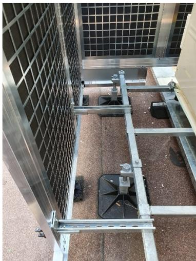
Beispielbild Montage mit Klemmverbindung zur Stahlrahmen:
