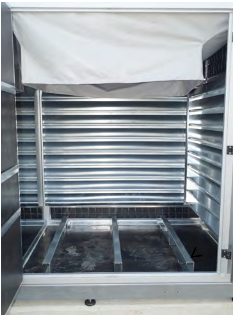
Querträger zur Aufnahme des Klima-, Kälte- oder Wärmepumpengerätes
