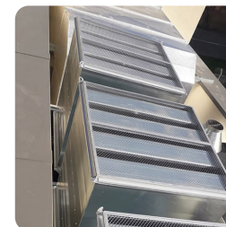
KULISSENSCHALLDÄMPFER 20 bis 30 dB Geräuschminderung
