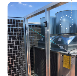
ROHRSCHALLDÄMPFER 10 bis 20 dB Lärmreduzierung
