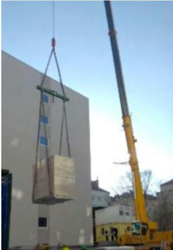
Pour le transport du caisson d'insonorisation on doit utiliser les anneaux de levage ou les supports de grue qui sont spécialement conçu à cet effet. Cela ne peut en aucun cas être installé sur le lien du coin supérieur.
