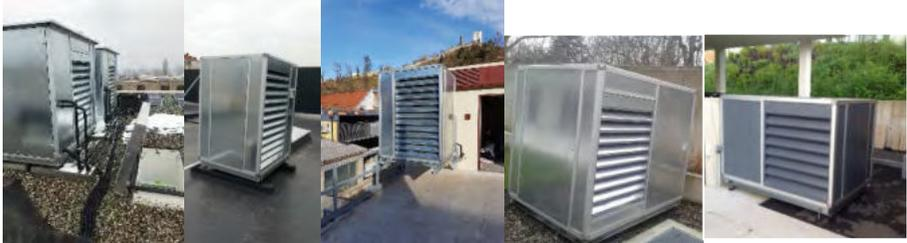
Le châssis de base et les anneaux de levage sont configurés de telles sortes que le refroidissement, la climatisation et la pompe à chaleur des unités extérieures peut être préassemblés dans le caisson d'insonorisation et peut être élevé ensemble avec la grue. Si les traverses et les unités extérieures de refroidissement, la climatisation et pompe à chaleur ne sont pas correctement attachées, nous ne sommes pas responsables pour les dommages ou les conséquences.
