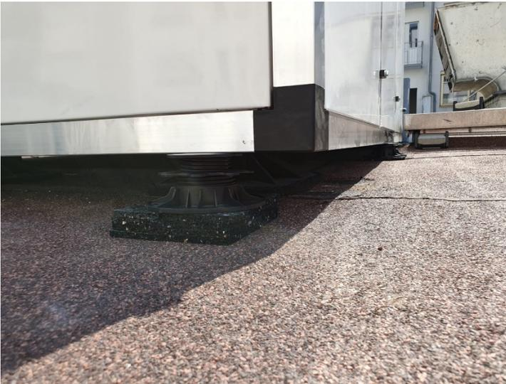
Exemple d'image Montage avec fixation au cadre Big Foot:
