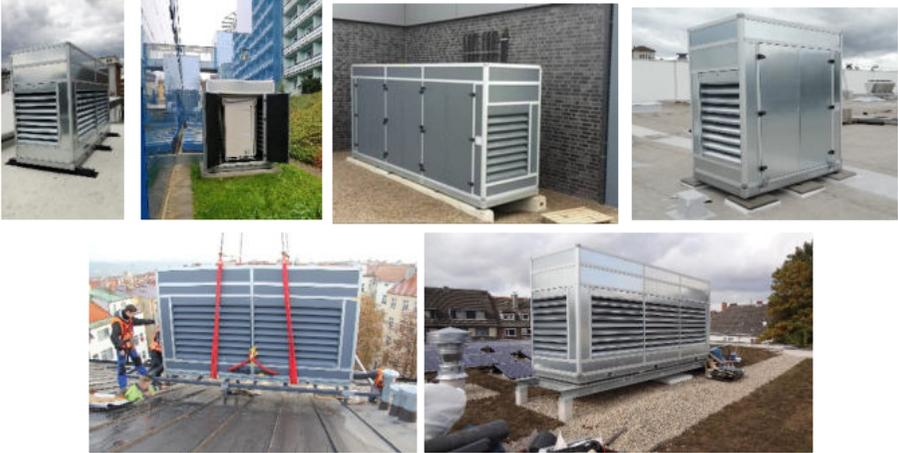
Le châssis de base et les anneaux de levage sont configurés de telles sortes que le refroidissement, la climatisation et la pompe à chaleur des unités extérieures peut être préassemblés dans le caisson d'insonorisation et peut être élevé ensemble avec la grue. Si les traverses et les unités extérieures de refroidissement, la climatisation et pompe à chaleur ne sont pas correctement attachées, nous ne sommes pas responsables pour les dommages ou les conséquences.
