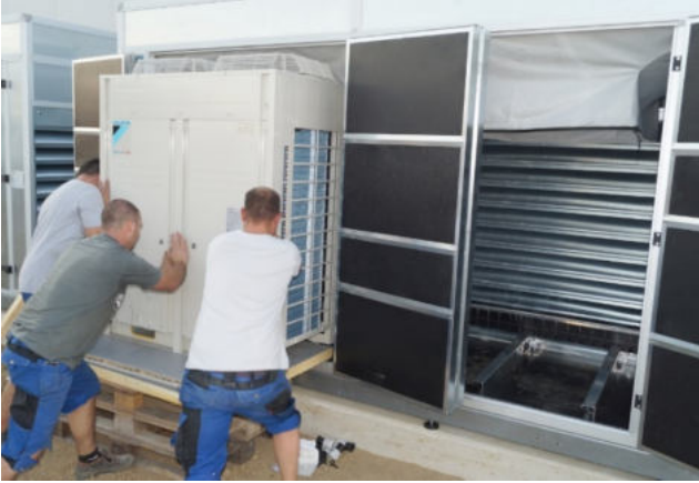
Uitlijning van de koel, airconditioning of warmtepomp buitenunits ten opzichte van het luchtscheidingsdeel
